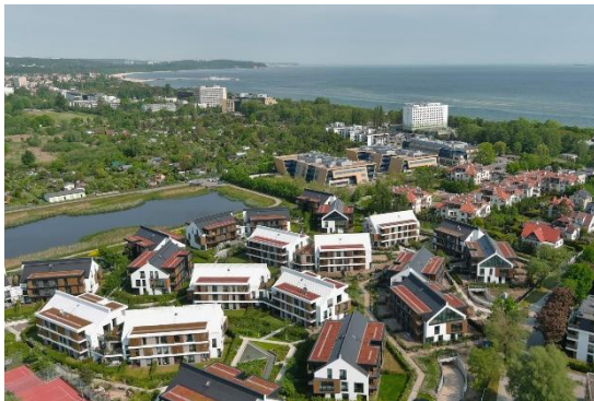
fot. widok z lotu ptaka
